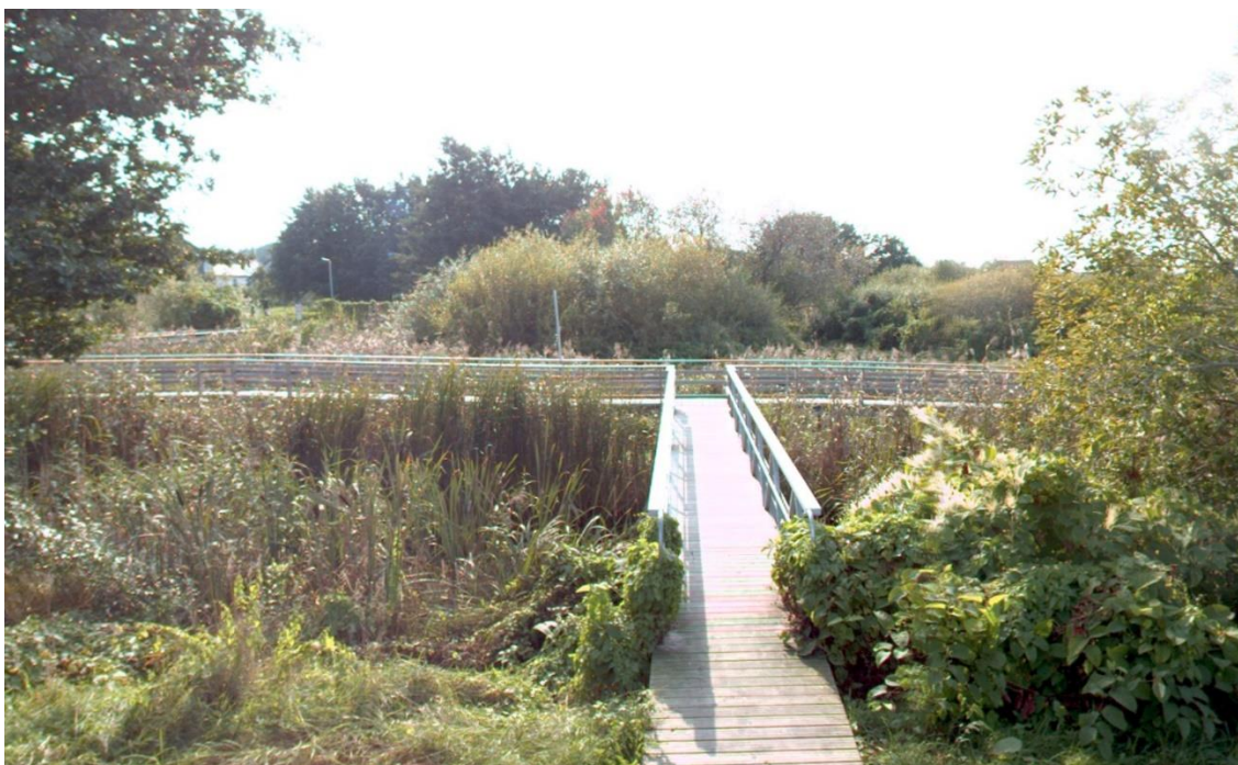
Joonis 3 Foto olemasolevast oja ületavast silla- ja laudteede konstruktsioonist
