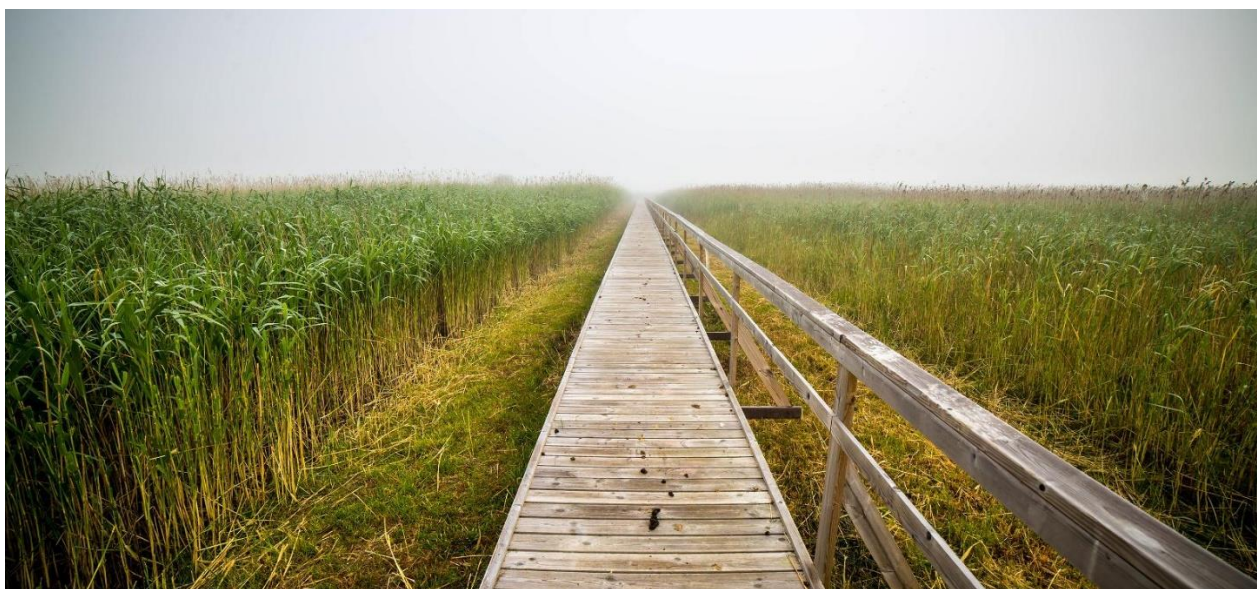
Joonis 9 Näide ühepoolse käsipuuga laudteest Orjaku õpperaja roostikus (Foto: RMK)
