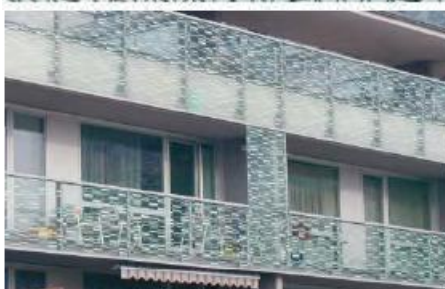
Joonis 29. Kasutatavad mustrid võivad olla nii pilte moodustavad kui ka regulaarse kordusega täpid ja triibud. Oluline oleks, et ei moodustuks mustrivabasid suuri avatud piirkondi. Allikas: Schmid jt 2008; City of Toronto Green Development Standard 2007.
